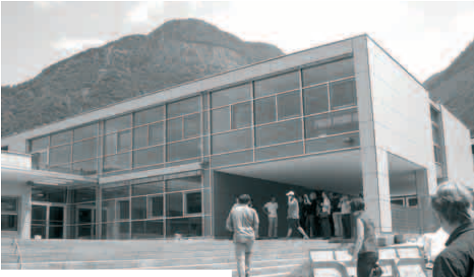
Die Schule in Branzoll als Passivhaus
