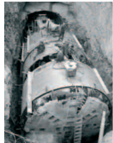
Eine Riesenfräse wird in Teilen vom Oberorthof transportiert
